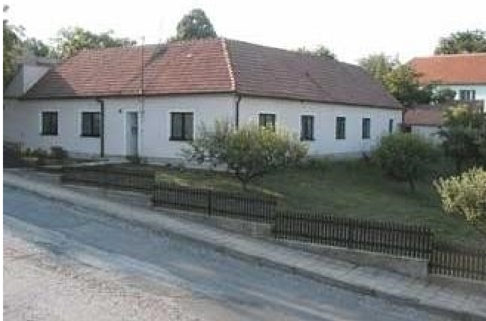
Obr. 3: Bývalá tvrz (Lukovany)
