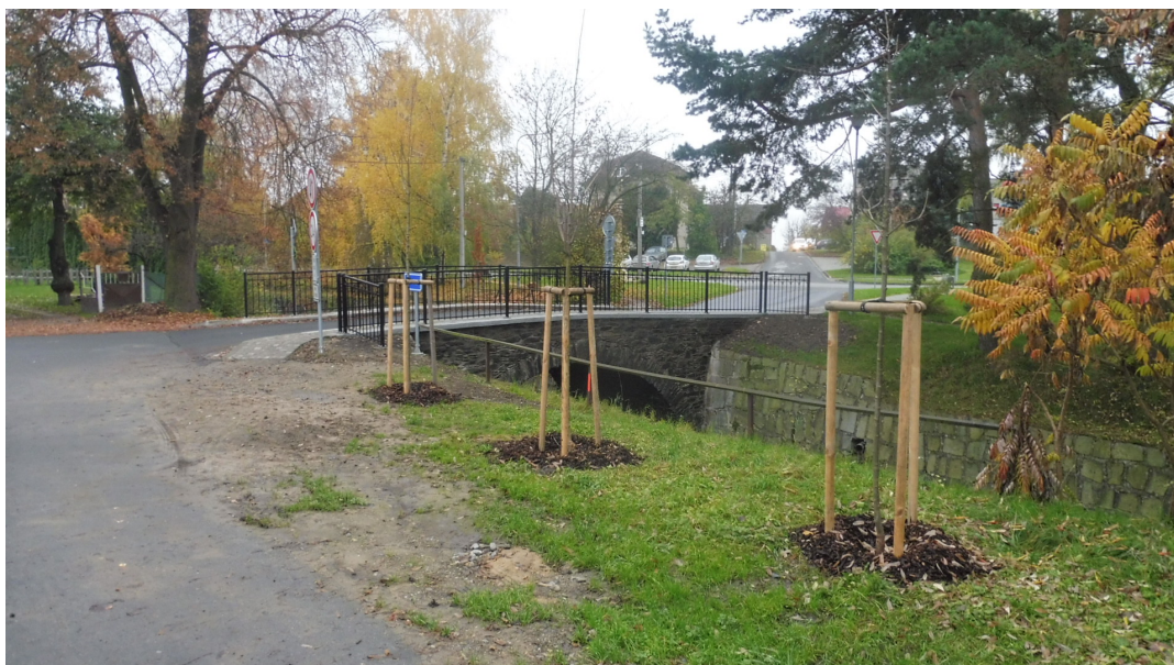
Obr. rekonstrukce mostu na návsi Zdroj: Obec Dlouhá Loučka
