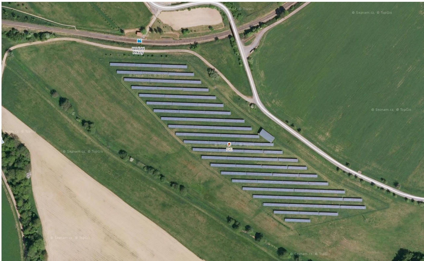
Obr. 4: Fotonvoltaická elektrárna na území obce Valašské Příkazy
