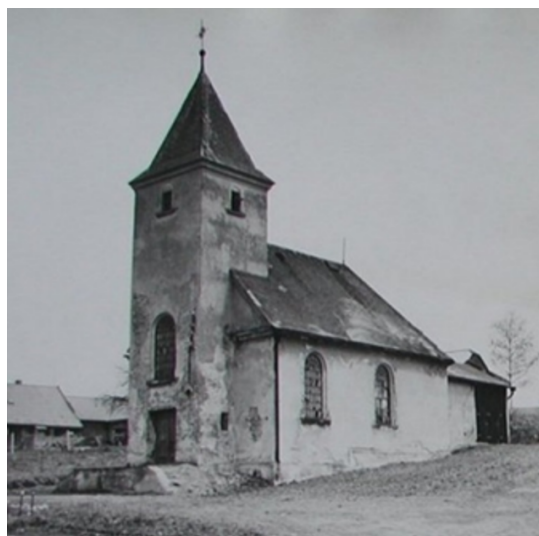
Obr. č. 6: Kostel sv. Josefa před rekonstrukcí,
