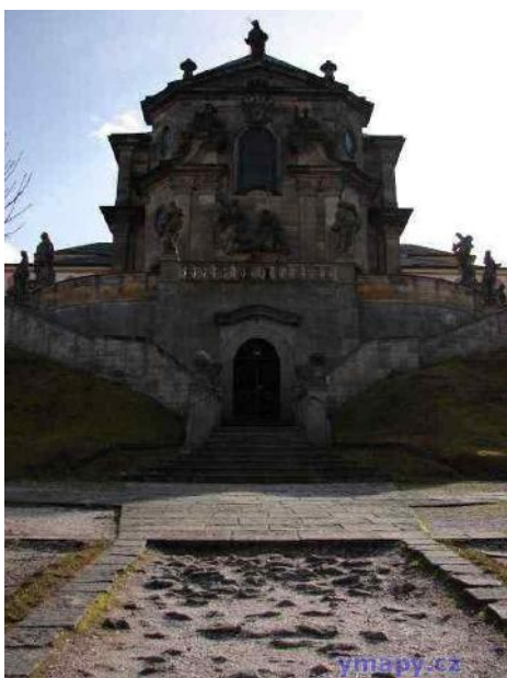
Hospital Kuks, vzdálenost 7 km
