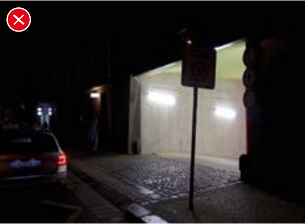
Extrémní případy silného přesvětlení garážových vjezdů nejsou příliš výjimečné. Vodorovné směřování zdrojů na snímku způsobuje velmi nepříjemné oslnění chodců i řidičů a navíc prakticky nedovoluje při příjezdu čist 4 dopravní značky před vjezdem. Takové uspořádání je v nočním režimu již opravdu nebezpečné (Praha 7, Česko).
