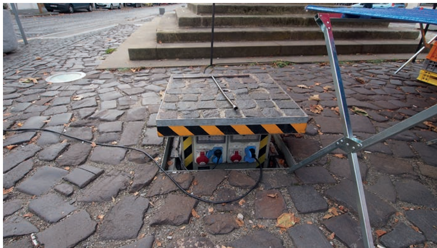
Obrázek č. 29 Staroměstské náměstí v Mladé Boleslavi: připojení na zdroj elektrické energie
