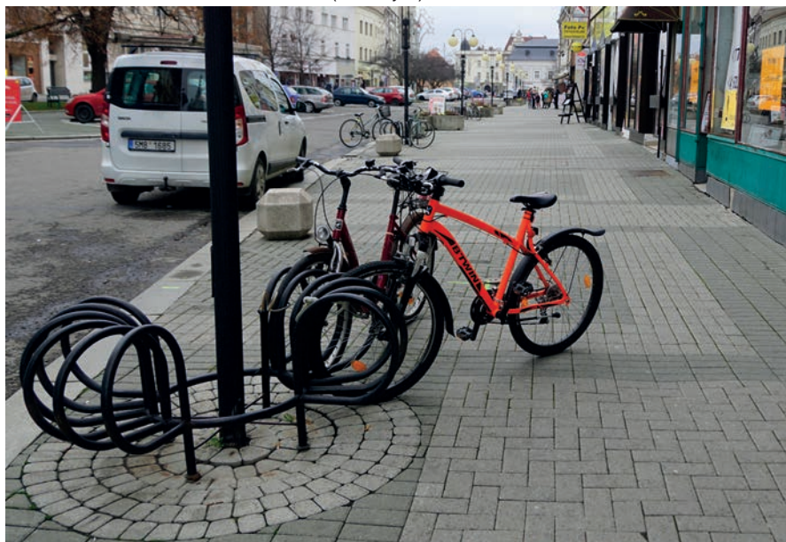
Obrázek č. 33 Příklad nevhodného řešení stání kol, kdy kola výrazně zasahují do chodníku i silnice (Prostějov)
