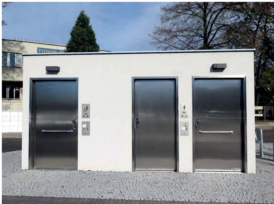
Obrázek č. 37 Příklad automatizovaných veřejných toalet (Strakonice)
